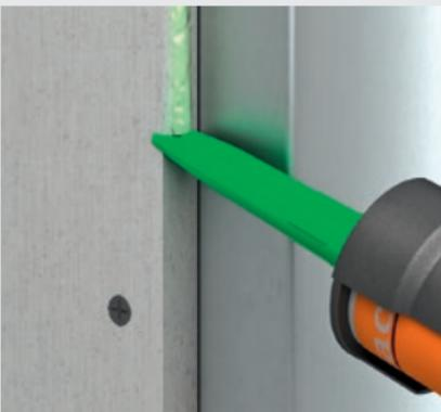
Dann den fermacell™ Fugenkleber auf die Plattenkante auftragen.
