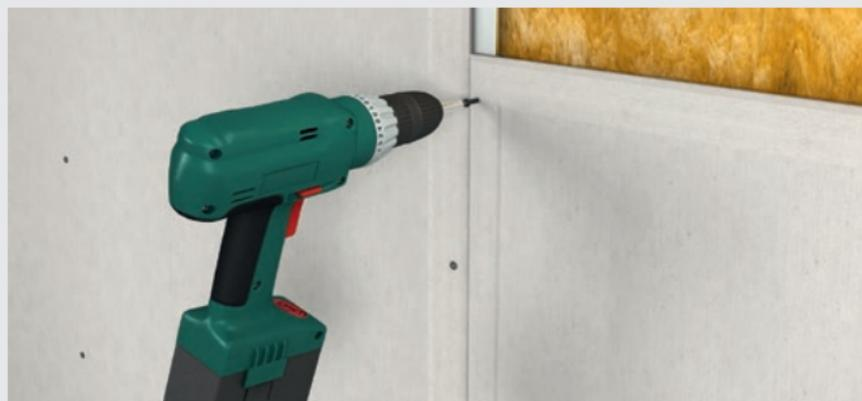
Schrauben auf Stahl-Unterkonstruktion
