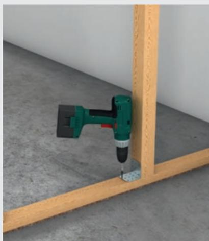
Montage der Holzständer mit Stiftnagel oder Stahlwinkel
