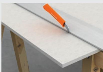
Die Platten mit dem fermacell™ Plattenreißer oder einem stabilen Klammensäge mit Hilfe einer Führung einritzen.
