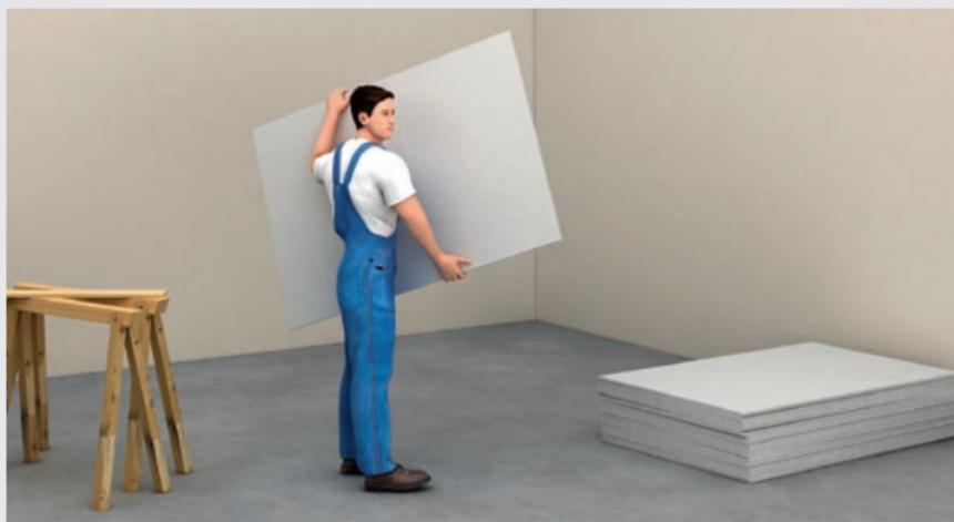
Einzelne fermacell® Gipsfaserplatten hochkant tragen
