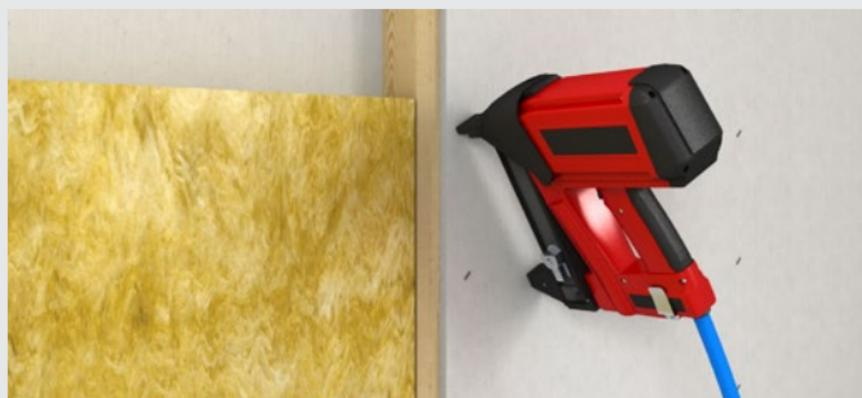
Klammern auf Holz-Unterkonstruktion
