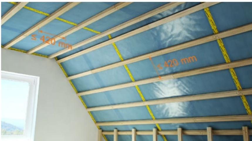
Achsabstände Unterkonstruktion bei Decken und Dachschrägen
