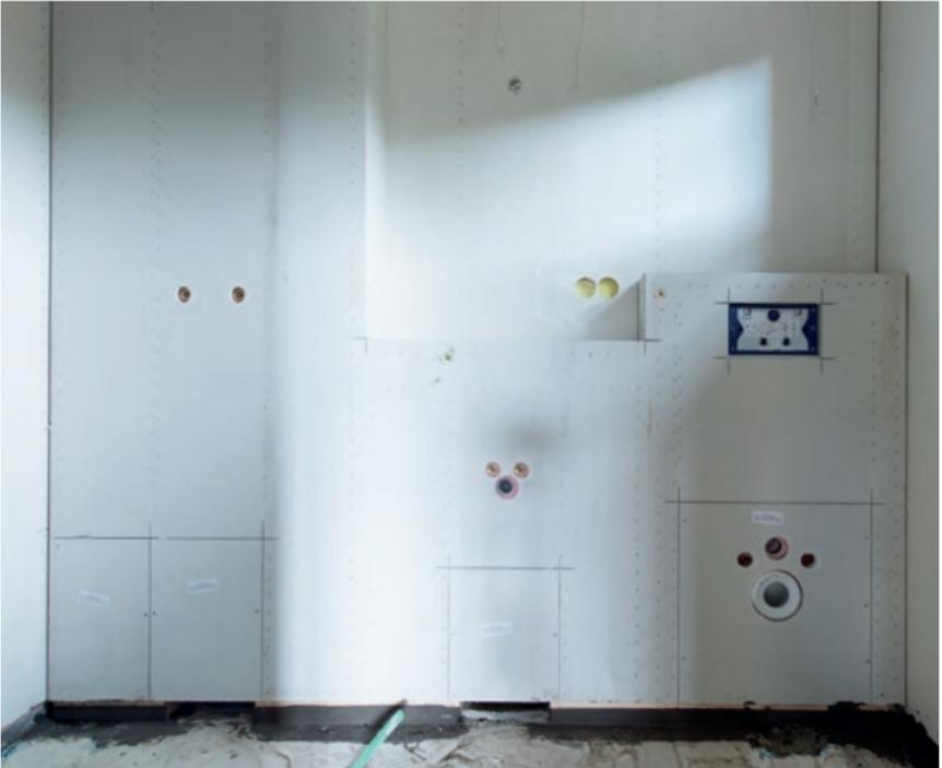
Für die Befestigung schwerer Konsollasten mit dynamischen Belastungen, wie z. B. Sanitärobjekten (Waschbecken, wandhängende WCs, Einbauspülkästen, Bidets, Urinale), ist in den fermacell® Wänden und Vorsatzschalen der Einbau statisch ausreichend dimensionierter Unterkonstruktionen, z. B. Sanitär-Tragständer, erforder-
