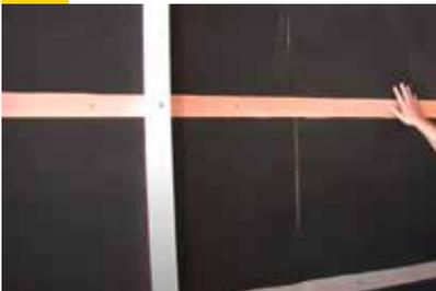
Auf die horizontal verlegten Rahmhölzer wird die Traglattung vertikal verlegt. Die Dicke und die Abstände der Traglattung ist so zu wählen, dass eine ausreichende Hinterlüftung gewährleistet ist und die Fassadenbekleidung sicher befestigt werden kann.
