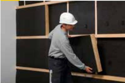
Für die zweite Lage der Dämmung werden die Rahmhölzer horizontal verlegt, auch hier entspricht die Stärke der zweiten Dämmebene der Dämmschichtdicke. Ansonsten gelten alle oben beschriebenen Anwendungshinweise.
