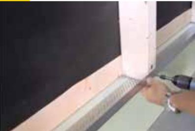
Um eine einwandfreie Funktion der Be- und Entlüftungsebene zu gewährleisten, sind im Sockelbereich und am Dachrand die Entlüftungsöffnungen mit mindestens 50 cm<sup>2</sup> je 1 m Wandlänge vorzusehen. Ist die Tiefe der Be- und Entlüftungsebene größer als 20 mm müssen die Öffnungen im Sockelbereich durch Lüftungsgitter gesichert werden.
