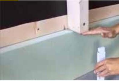
In der Regel wird der untere Abschluss der VHF mindestens 30 cm oberhalb der Geländeoberkante angeordnet. So wird eine einwandfreie Funktion der Be- und Entlüftungsebene gewährleistet und die gedämmte Fassade wird im Spritzwasserbereich geschützt. Bei einem verputzten Sockel werden die Styrodur 2800 C Platten mit einem geeigneten Klebemörtel im Wulst-Punkt-Verfahren dicht gestoßen verlegt, nachträglich mit Dübeln befestigt und anschließend nach Angaben des Systemanbieters verputzt.
