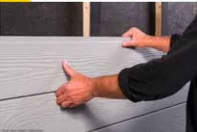
Vor Montage der Fassadenbekleidung, werden die Rahmenhölzer mit einer Trennschicht (z.B. EPDM Band) geschützt. Dies gilt auch für Außenecken und Fensterlaibungen. Das Band wird von oben nach unten angebracht. Nun kann die Fassadenbekleidung montiert werden. Die Verlegehinweise des Fassadenbekleidung-Herstellers sind zu beachten. Ab einem Fugenanteil von mehr als 5 % ist eine Fassadenbahn auf den horizontalen Rahmenhölzer erforderlich.
