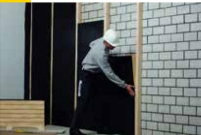
Die ULTIMATE FSP-031/034 Fassadendämmplatten werden lückenlos und dicht gestoßen zwischen den Rahmenhölzern eingebaut. Die Fassaden-Dämmplatten müssen nach der Befestigung vollflächig an der Tragwand anliegen, eine Hinterströmung ist zwingend zu vermeiden, ggf. ist eine zusätzliche Fixierung erforderlich.
