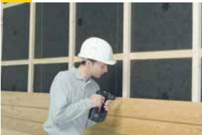
Wird die Traglattung so montiert, dass die Fassaden-Dämmplatten mindestens durch zwei Traglatten pro Platte gesichert werden, kann auf eine Verdübelung der zweiten Dämmlage verzichtet werden. Wenn das nicht der Fall ist, wird durch beide Dämmstofflagen wie oben beschrieben verdübelt. In diesem Fall entfällt die Verdübelung der ersten Lage.
