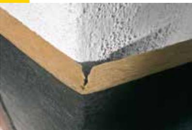
Die ULTIMATE Fassaden-Dämmplatten sind vielseitig einsetzbar. So lassen sie sich beispielsweise einfach um die Ecke verlegen. Dazu auf der Rückseite einen Keil ausschneiden und die Platte knicken. Die flexiblen Platten lassen sich biegen, ohne zu brechen, und gehen auch nach mehrmaligem Zusammendrücken wieder auf.
