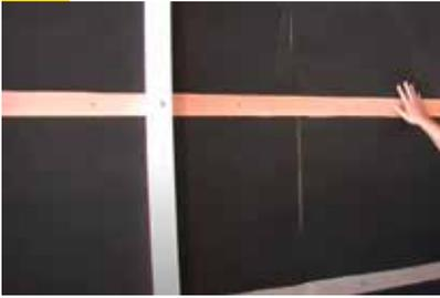
Bei der Ausführungsvariante mit horizontale Grundlattung werden die Fassadendämmplatten auch bündig mit den Rahmenhölzer eingebaut. Die Traglattung wird vertikal verlegt, um den Hinterlüftungsquerschnitt zwischen Dämmschicht und Bekleidung herzustellen. Durch die Dicke der Traglattung ist eine ausreichende Hinterlüftung zu gewährleisten. Ansonsten gelten alle oben beschriebenen Anwendungshinweise.
