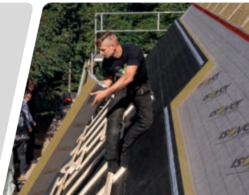
Schlanker Aufbau mit  $\lambda_D 31$ : Mit ULTIMATE lässt sich ein U-Wert von 0,14 mit nur 160 mm Zwischensparrendämmung und 80 mm Aufsparrendämmung erreichen.
