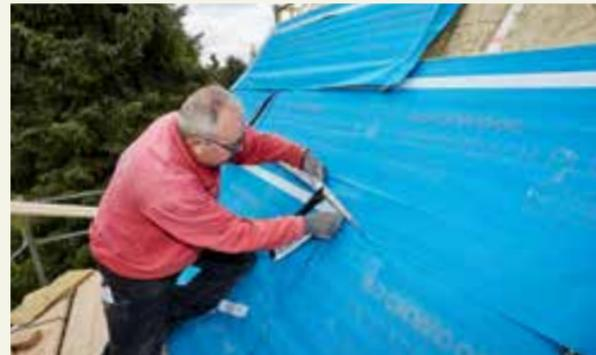
Sorgfältiges Verkleben der Überlappungen der bereits auf die Dachdämmplatte aufkaschierten diffusionsoffenen Unterdeckbahn schützt vor Witterungseinflüssen.
