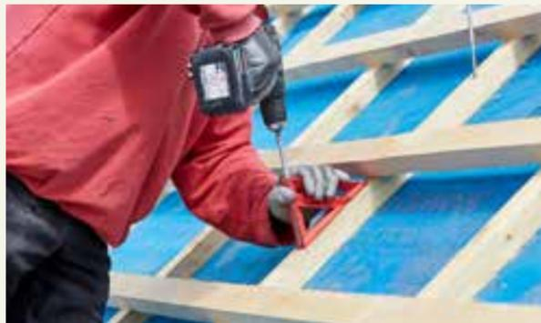
Die anschließende Konterlattung wird durch wechselseitiges Einbringen der Doppelgewindeschrauben gemäß Verlegeplan sicher befestigt.
