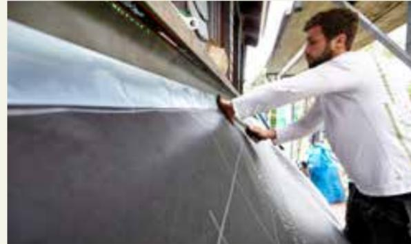
Kommt für die Sanierung die Luftdichtungsbahn RockTect Meditop infrage, wird diese Folie zeitsparend in einer Ebene über die Sparren verlegt.
