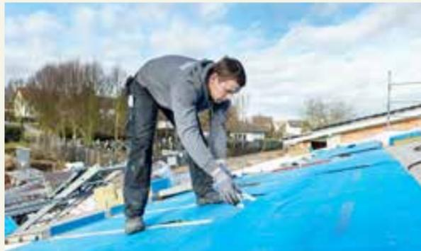
Direkt auf die Luftdichteitesebene wird die Dachdämmplatte Masterrock im Verband verlegt. Ihre Druckfestigkeit gibt Sicherheit bei der Verlegung.
