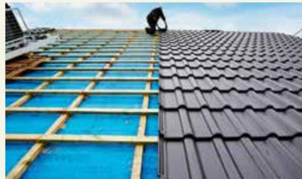
Im Anschluss an die Einlattung erfolgt die Eindeckung mit neuen (oder gut erhaltenen alten) Dachziegeln: Das nun hervorragend gedämmte Dach kann sich sehen lassen.
