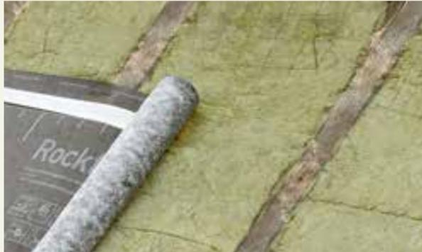
Nach Entfernen der alten Materialien und Freilegung der Sparren kann der Einbau der Zwischensparrendämmung Klemmrock von außen erfolgen.
