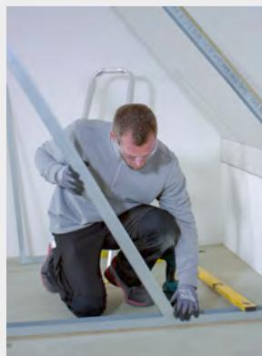
Um Schallbrücken zu minimieren, verlegen Sie zwischen Wand bzw. Decke und den Anschlussprofilen am besten zunächst ROCKWOOL Randstreifen. Nach dem Andübeln der Anschlussprofile werden die Ständerprofile eingestellt und ausgerichtet. Danach wird die Bekleidung aus Gipskartonplatten (GKB) auf einer Seite der Profile verschraubt.
