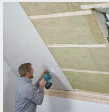
In diesem Bereich können Installationen oder Kabel verlegt werden, ohne die Dampfbremse zu beschädigen. Abschließend kann eine Wandbeplankung, z. B. aus Gipskartonplatten, angebracht werden.
