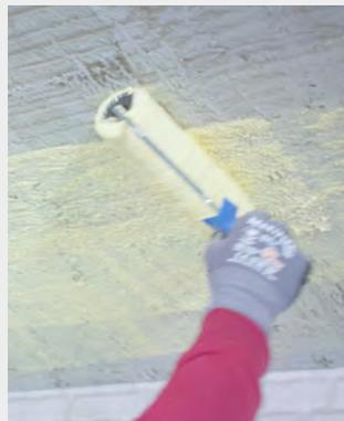
Die Deckenoberfläche muss vor der Verlegung der Dämmplatten gesäubert und auf Tragfähigkeit geprüft werden. Eventuell ist die Decke vor Verklebung der Dämmplatten mit einer Haftgrundierung zu streichen.
