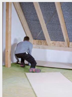
Anschließend kann die gedämmte Fläche z. B. mit Spanplatten belegt werden. Die Verwendung von Nut- und Federspanplatten ermöglicht einen sicheren Verbund der Decklage. Eine Verklebung der Plattenfugen ist nicht erforderlich.
