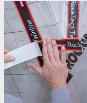
Für luftdichte Abschlüsse von Durchdringungen wird das Folienklebeband RockTect Twinline verwendet. Dabei ist auf eine sorgfältige dichte Verklebung zu achten. Es empfiehlt sich, mit 5 bis 10 cm langen Klebestreifen zu arbeiten. Anschlüsse an Dachflächenfenster können ebenso ausgeführt werden.
