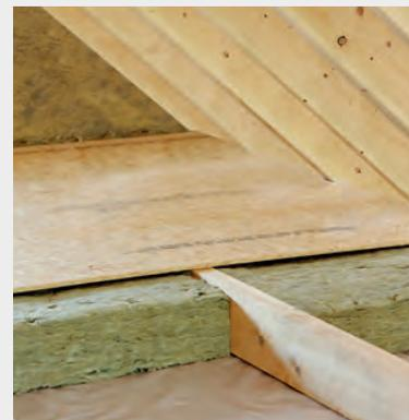
Bei Dachböden, die als Abstellraum genutzt werden sollen, wird Klemmrock zwischen den ausgelegten Kanthölzern ausgerollt und mit Spanplatten abgedeckt.
