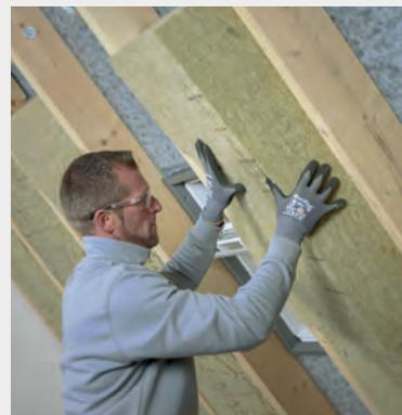
Klemmrock lässt sich nun leicht zwischen die Sparren klemmen. Sie sitzt sofort sicher und gut und passt sich konturgenau den Sparren an. So dämmen Sie Ihr Schrägdach perfekt. Informationen zum luftdichten Abschluss finden Sie auf den Seiten 20 und 21.
