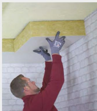
Danach die Dämmplatte mit der flachen Hand an die vorbehandelte Decke drücken und fixieren. Planarock Top besitzt dank einer Vlieskaschierung bereits eine fertige Oberfläche. Sollte ein nachträglicher Farbanstrich gewünscht sein, ist die dazu speziell beschichtete Planarock Paint die richtige Wahl.
