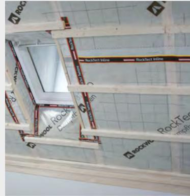
Vor die Dampfbremssfolie wird eine Lattung als Unterkonstruktion für die Beplankung auf die Sparren geschraubt. Der lichte Abstand zwischen den Latten muss bei einer Querverlegung der Gipskartonplatten 45 cm betragen.
