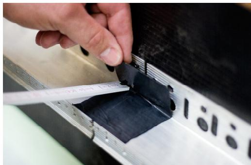
Anschließend können die INTHERMO Sockelstreifen/ Streifen/Dämmungen aus Kork oder XPS in die Sockelschienen eingelegt werden.
