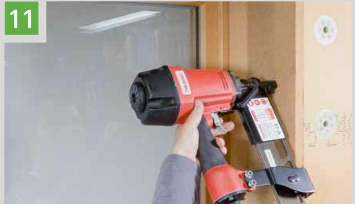
Fixierung der Laibungsplatte mittels Breitrückensklammern oder Edelstahlschrauben (Anpressdruck zur ungestörten Aushärtung von STEICO*multi fill*)
