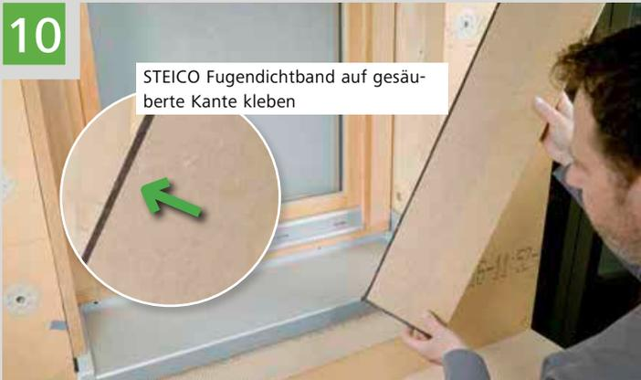
STEICO Fugendichtband auf gesäuberte Kante kleben
