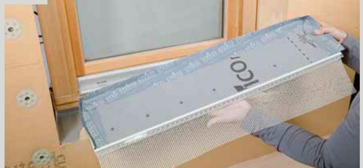
Im Anschluss die STEICOmulti tape F 20/40 mm Klebestreifen so auf dem Dämmkeil anbringen, dass eine dreiseitige „Wanne“ ausgebildet wird.
