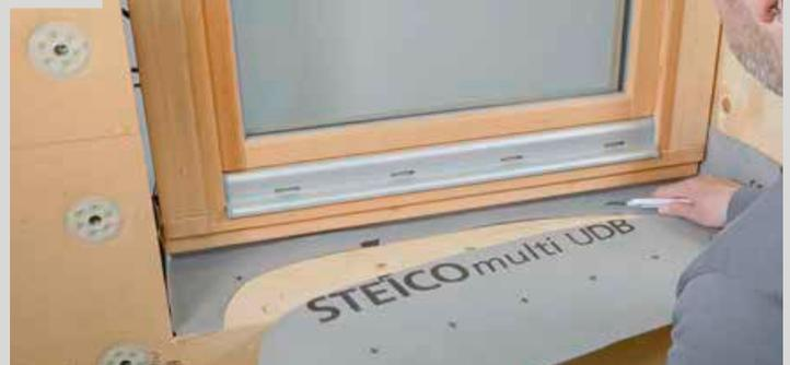
Vor Montage von STEICOfix 2.0 die Bahn trapezförmig zurückschneiden
