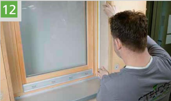
Setzen der Anputzleiste auf gereinigten Fensterrahmen gegen die Holzfaserdämmplatte .
