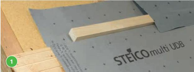
Vor der Verlegung von STEICOsafe sind Anschlüsse am Vordach im Trauf- und Ortgangbereich mit STEICOmulti UDB auszuführen. Um eine gerade Verlegung zu gewährleisten, empfehlen wir im Traufbereich einen Lagerriegel mit analoger Höhe zur verwendeten Plattendicke zu montieren.
