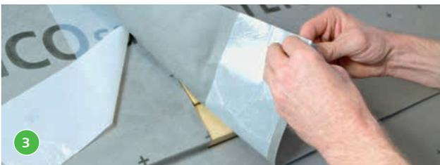
Der unterseitige Folienüberstand wird mit dem integrierten Selbstklebestreifen auf das Lagerholz als auch auf die Unterdeckung des Vordachbereiches geklebt.
