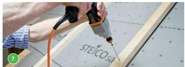
Im Anschluss erfolgt die Montage der Konterlatten mittels Schrauben oder Nägel.
