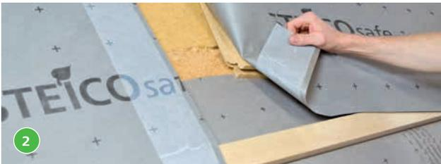
Mit der Verlegung wird an der Traufe unten links begonnen. Die Nut der untersten Plattenreihe muss nicht entfernt werden, sofern sich der Lufthohlraum (Nut der N&F Verbindung) außerhalb der thermischen Hülle (letzte Dämmebene der Außenwand) befindet. Ist dies nicht der Fall, kann der Lufthohlraum mit STEICOflex vorab ausgestopft werden. Sofern die Nut weggeschnitten wird, muss dies ohne Beschädigung des Folienüberstandes erfolgen.
