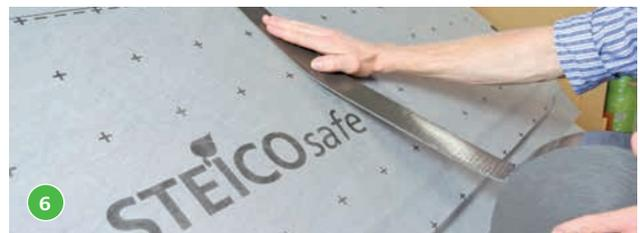
Die Verlegung und Verklebung der folgenden Plattenreihen erfolgt analog. Nach der vollflächigen Verlegung werden die notwendigen Detailanschlüsse ausgeführt.
