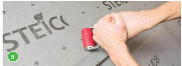
Die Verklebung des Vertikalstoßes ist vor der Verklebung des Horizontalstoßes durchzuführen. Die Klebeflächen sind mit einem Hartgummiroller fest anzupressen.
