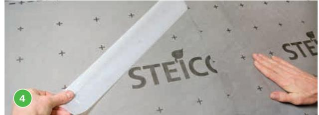
Die Folienüberstände der folgenden Platten werden aufgeklappt, und die Platten positioniert. Die Verklebung ist im Weiteren erst durchzuführen wenn eine weitere Plattenreihe verlegt wurde. Somit wird eine Verschmutzung der Klebefläche ausgeschlossen.
